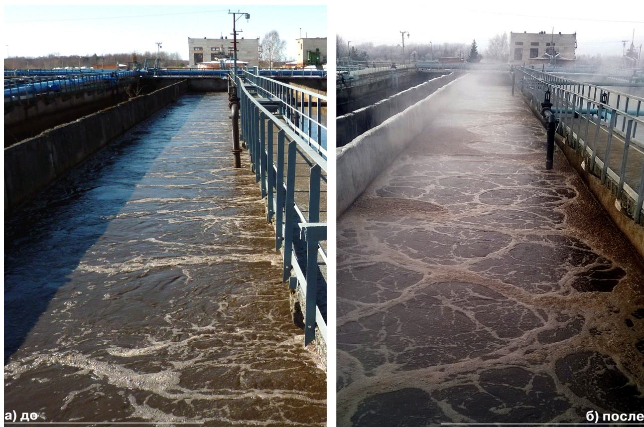
Рис. 4. Сравнение интенсивности аэрации до и после установки новой аэрационной системы в секции аэротенка КОС г. Тихвин
