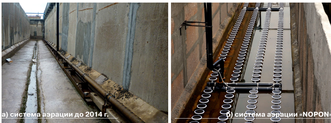
Рис. 3. Аэрационные системы аэротенка КОС г. Тихвин
