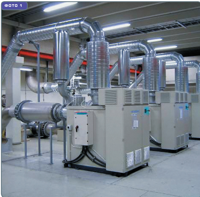
ФОТО 1 ЕДИНАЯ СИСТЕМА ИЗ ЧЕТЫРЕХ ТУРБОВОЗДУХОДУВОК SULZER HST
