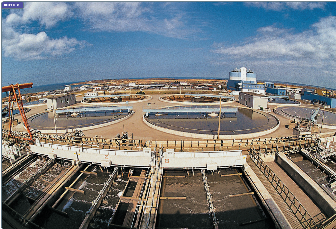
ОЧИСТНЫЕ СООРУЖЕНИЯ КАНАЛИЗАЦИИ, Г. КАСТЕЛЬОН-ДЕ-ЛА-ПЛАНА, ИСПАНИЯ
